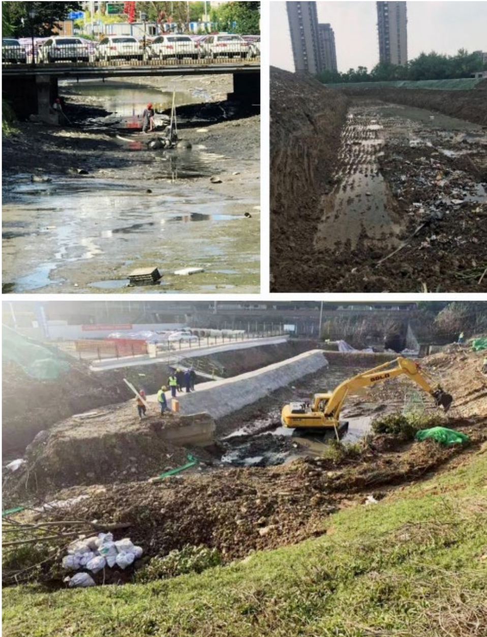
黑臭水河道治理工程
