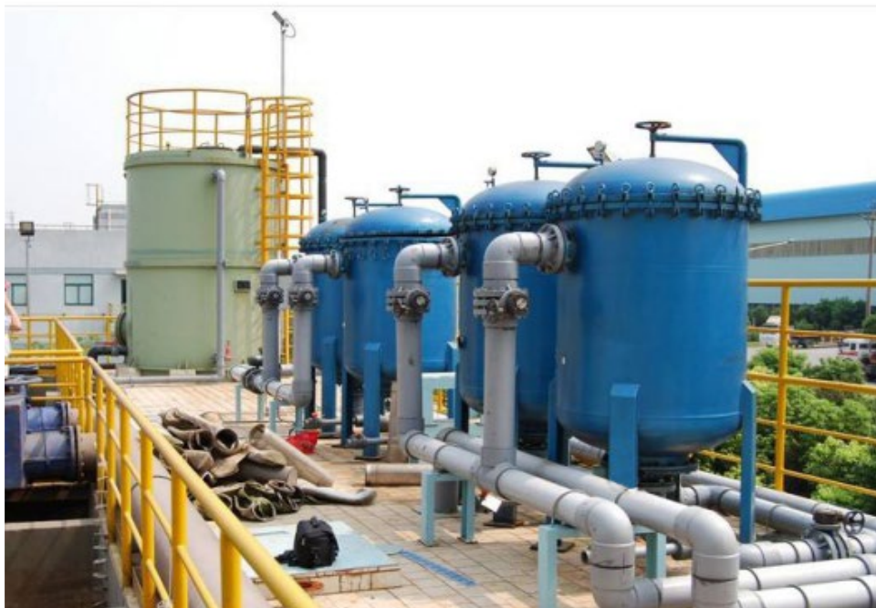
新材料产业园污水处理厂
