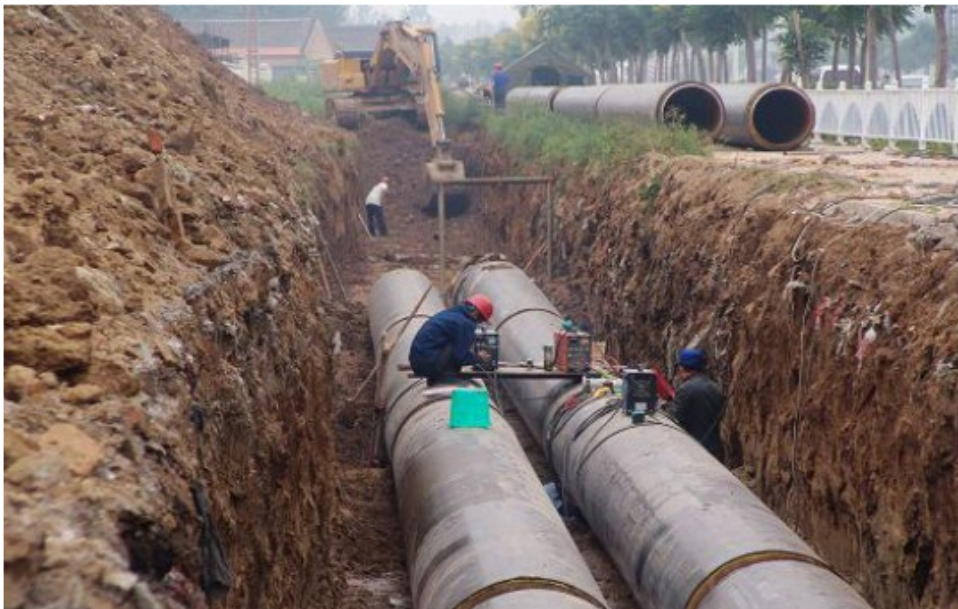
市政管网建设工程
