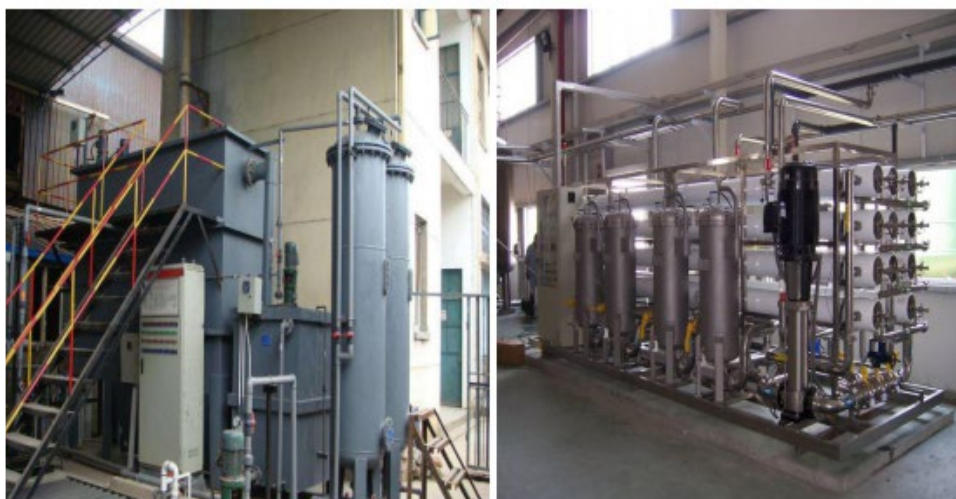
生物工程公司废水处理工程
