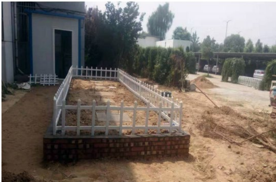
污水处理站一体化设备安装项目
