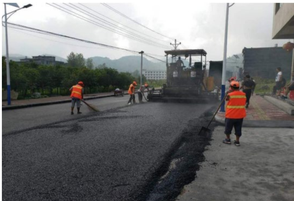
市政道路建设工程
